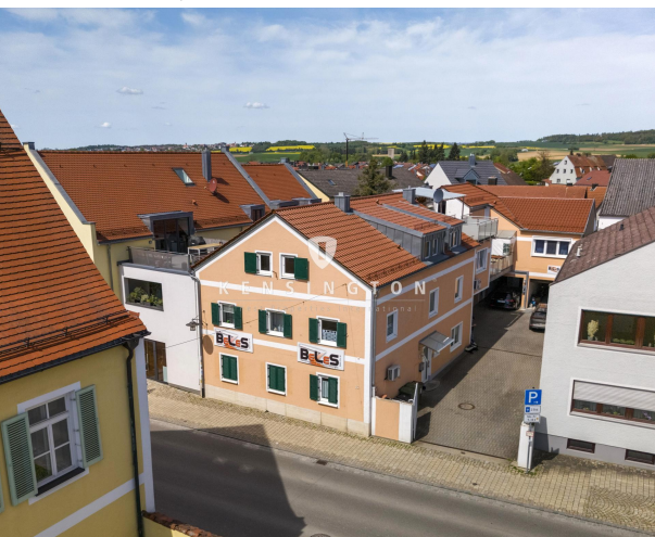
Generalsaniert, PV uvm!
